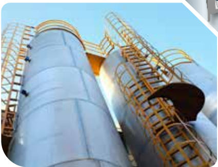
Hammadde depolama siloları Raw material storage silos
