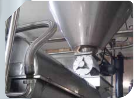
Üretim hattına hammadde beslenmesi Feeding of bulk solids to production line
